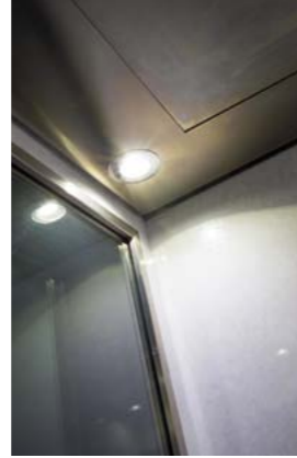
KABINENDECKE IN EDELSTAHL MIT LED SPOTS UND KABINEN- LICHTABSCHALTUNG
