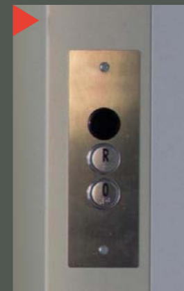
RUFTABLEAU ALS EDELSTAHPLATTE MIT TAKTILEN TASTERN MIT BRAILLE-SCHRIFT
