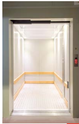
BLICK VON AUSSEN IN DIE KABINE
