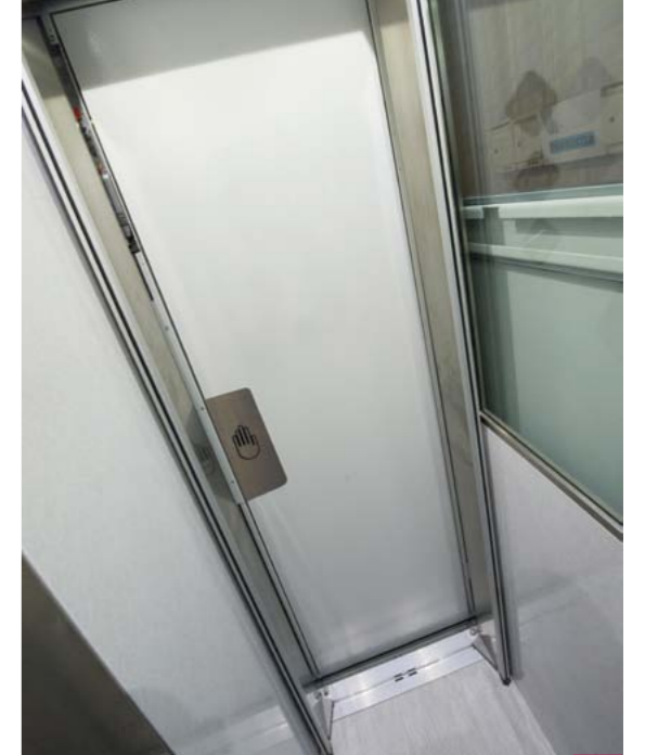
KABINENTÜR ALS AUTOMATISCHE FALTTÜR, IDEAL BEI KLEINEM AUFZUGSSCHACHT
